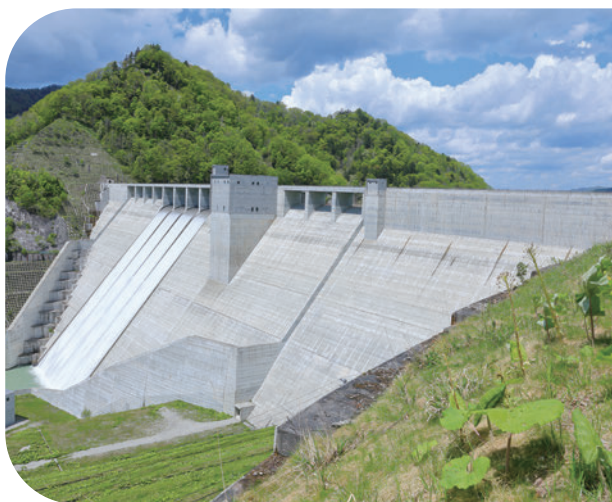
夕張シューパーダム【日本工営】
