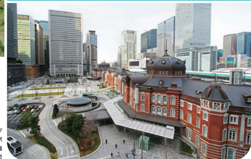
丸の内広場および 八重洲広場整備東京駅 北通路周辺再整備 【JR東日本コンサルタンツ】
