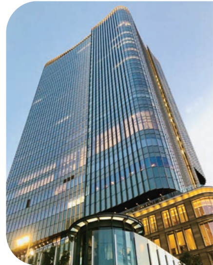
東京ミッドタウン日比谷 【鹿島建設】
