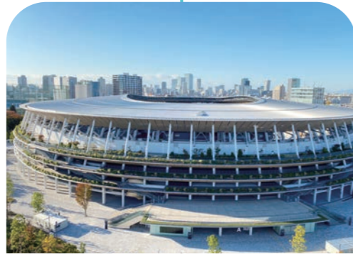
新国立競技場 【大成建設】
